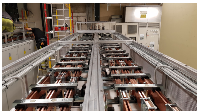
Inga tunga lyft – fixera kapslingen på plats och montera kopparskenorna efteråt.
